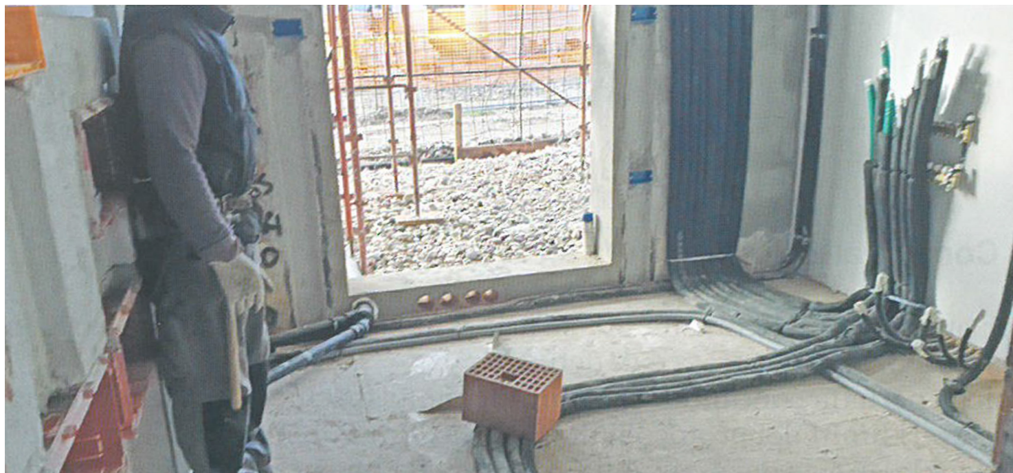
1/3 LATO INTERNO. Realizzazione dei passaggi impiantistici: i fori passanti da interno verso esterno, vano scala o altra unità abitativa (vedere schema nella pagina precedente) è preferibile che vengano realizzati sotto gli infissi forando il quarto lato distanziando i fori per evitare distribuzioni a grappolo. Il distanziamento tra le tubazioni risulta fondamentale per la corretta esecuzione del lavoro.
